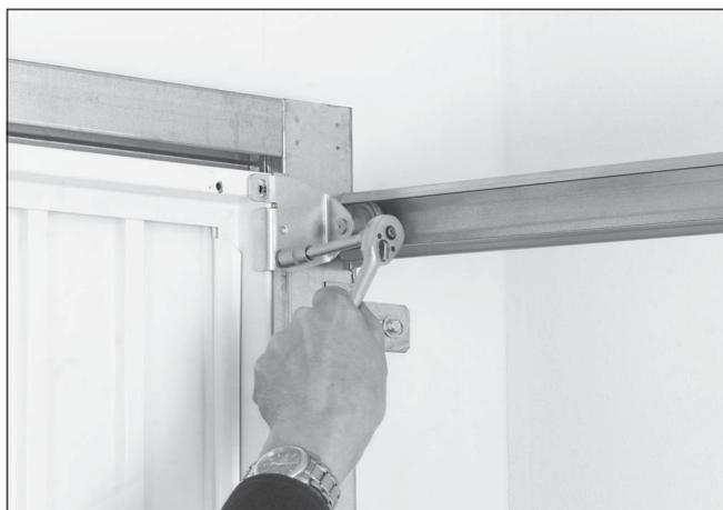
1. Demontieren Sie zuerst nur den **rechten** Rollenbock und nehmen Sie ihn aus der Laufschiene heraus.
