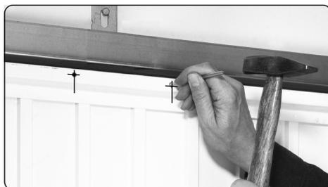
2. Schlagen Sie die Befestigungslöcher mit Hilfe des beiliegenden Schlagdorns in den Torrahmen.
