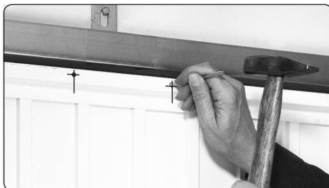
2. Faites les trous de fixation dans le cadre de porte au moyen du mandrin ci-joint.
